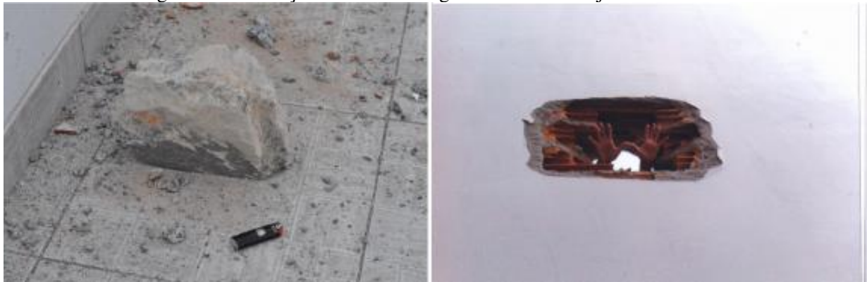
Figura 2: Ultralançamento de rocha granítica em 03 de junho de 2014.
