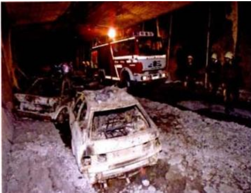
Figura 4. Túnel de Tauern após a tragédia Fonte: Meireles, (2008).
