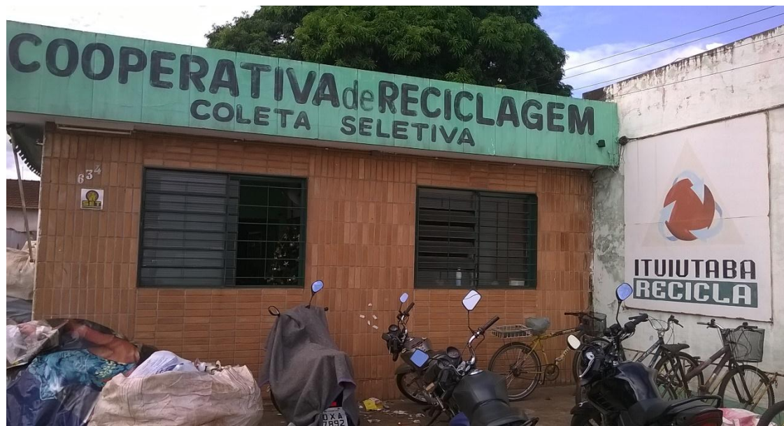
Figura 1- Sede da COPERCICLA
